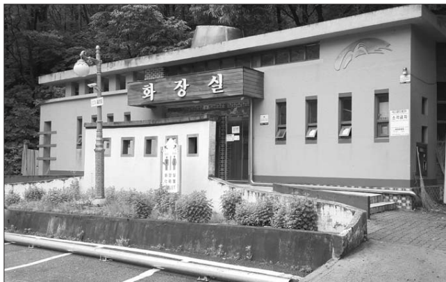
진안군은 18일 마이산 남부 1·2주차장 내 낡은 화장실을 최고급 화장실로 신축한다.
