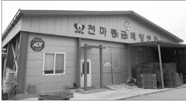
무주군 천마종균배양센터 전경
