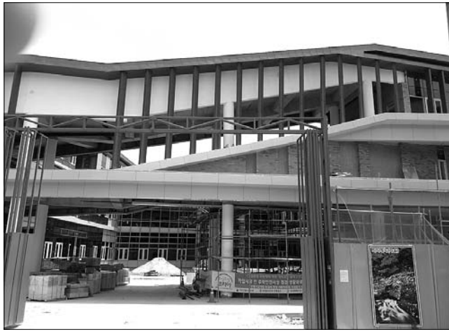
장수군 증축청사의 북쪽 도로변 쪽 2층에서 3층으로 가는 계단 통로의 양옆의 높이 약 3.5m, 지름 40cm인 4개의 시멘트 기둥이 육안으로 봐도 확연히 기울어 있다.
