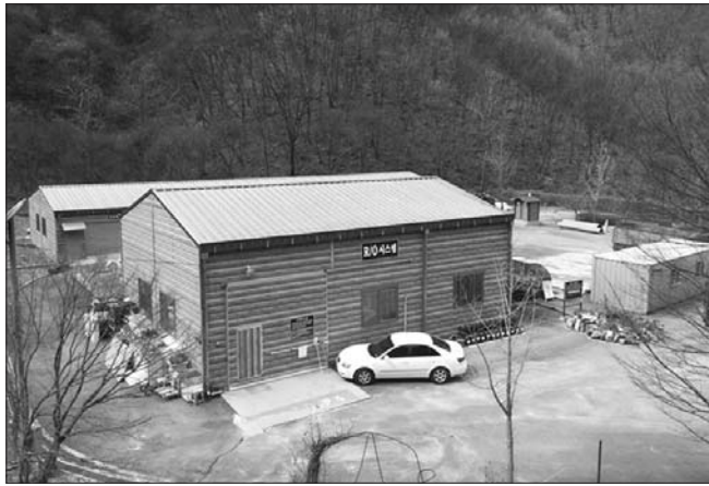
무주군이 폐기물종합처리장 침출수처리시설 보강사업 추진에 필요한 도비(특별조정교부금) 6억 원을 확보했다.(사진은 침출수처리시설)
