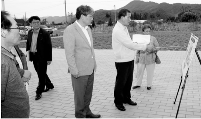
유진섭 정읍시장은 올해 11월 중 개관 예정인 애국지사 박준승 기념관 건립공사 현장을 방문했다.
