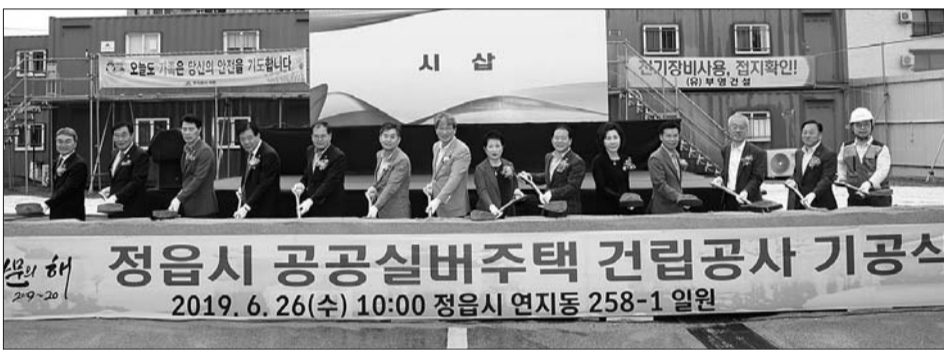
정읍시가 26일 고령친화형 사회복지시설과 공공임대주택이 복합 설치되는 '공공실버주택' 건립을 위해 첫 삽을 떴다.
