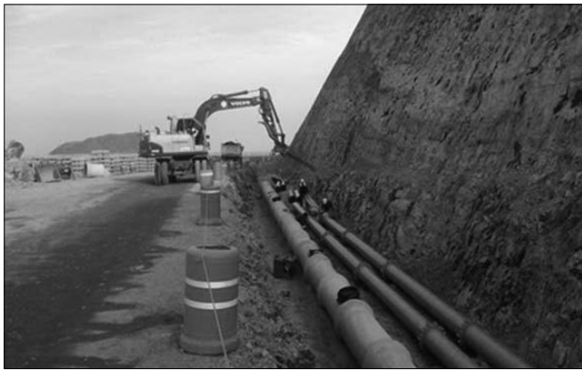
군산시는 지난 7월 고군산군도 연결도로 부분개통에 맞춰 신시도~무녀도(고군산대교)까지 상수도관 매설을 완료했다.
