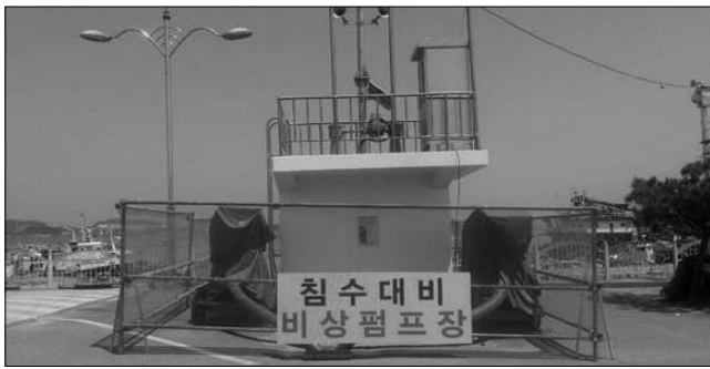
시공사의 공사 포기로 차질을 빚던 '군산 내항 빗물저장시설공사'가 재개됐다.
