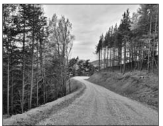
특히 용출수 발생 구간에 담수시설을 설치하고, 습지 내 토양을 치환하며 나온 점토질 토양을 사면에 뿌려와 혼합시공함으로써 집적력과 발아력을
