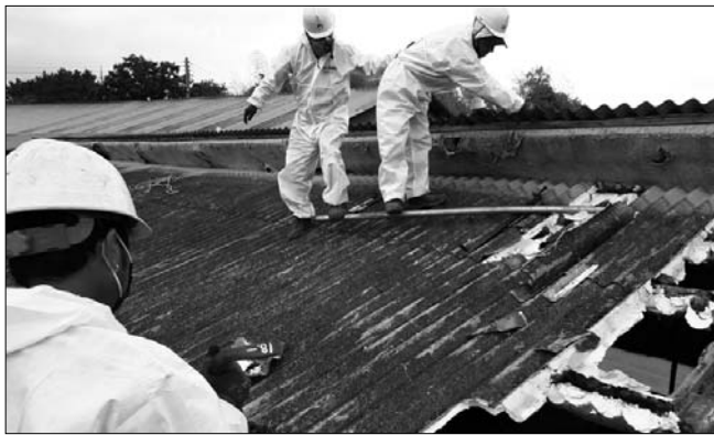
부안군은 발암물질인 석면으로 인한 군민의 피해를 예방하고자 국비를 지원받아 슬레이트 철거 지원사업을 추진 중이다
