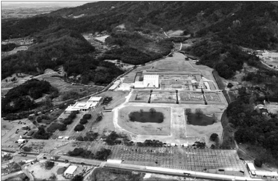
익산시와 문화재청은 백제왕도 핵심유적 보존관리사업의 하나로 익산 미륵사지(사적 제150호) 내 강당지, 동·서 승방지, 동원 회랑 등의 기반부와 강당지 앞 배수시설 개선을 위한 유적 정비를 본격적으로 착수한다. 사진은 미륵사지터
