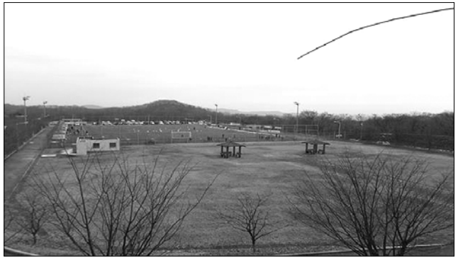
군산시 수도과는 군봉배수지 외 2개소에 대해 2019년까지 3년에 걸쳐 총 36억5700만원의 예산을 투입하여 배수지 내부 재도장 등의 보수 공사를 실시한다고 밝혔다.
