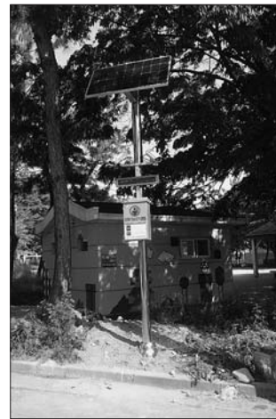
군산시 수송동은 청소취약지역 4개소에 블랙박스형 CCTV를 설치했다.
