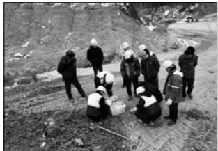
성상(오염도) 조사에 따라 조사된 오염폐기물 범위를 심도별로 굴착해 이적 처리하고, 오염되지 않은 폐기물·토양은 사업장 내 적치 후 오염 여부를 재차 분석·검증해 재매립 여부를 판단할 계획이다.
