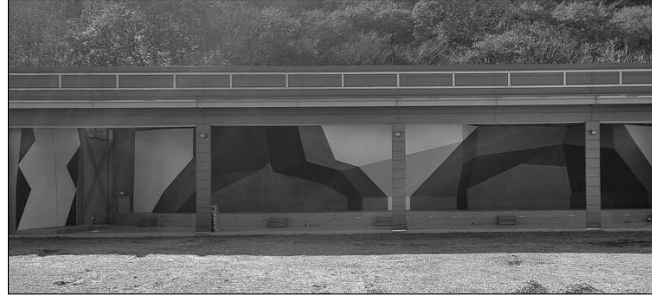
군산시가 이달 소용동에 위치한 군산인공암벽장에 국제규격의 볼더링장(L43m x H13m)을 선보인다.
