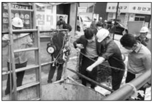
인해 하수관로 30.4km, 배수설비 3,144가구를 정비한다.
