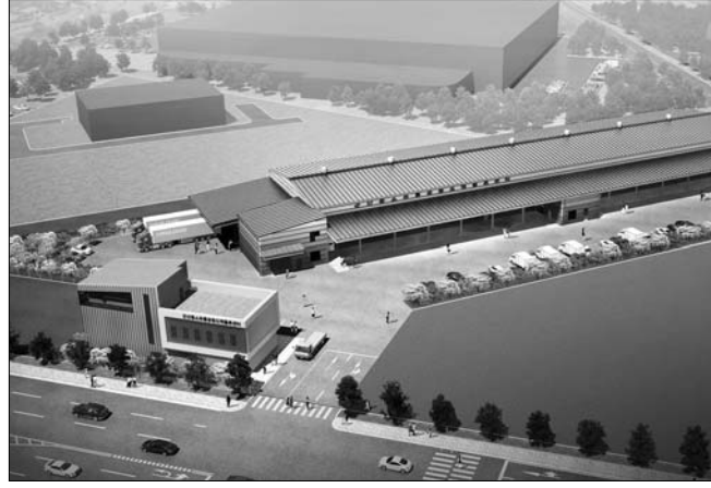
군산시는 3월부터 '군산중소유통공동도매물류센터(이하 중소유통물류센터)' 건립을 위한 본격적인 공사에 들어간다.
