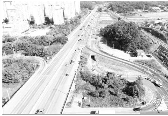
군산시는 1일부터 군산대IC의 불완전 교차로 구조개선을 통해 옥구읍방향에서 새만금북로 우회전 진입이 원활해진다고 밝혔다.
