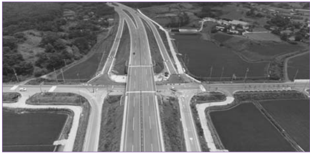
익산지방국토관리청에 따르면 전체 8.8Km 구간 중, 3.8Km 구간을 4차로로 조기 준공해 오늘 낮 12시부터 차량통행을 시작한다.
