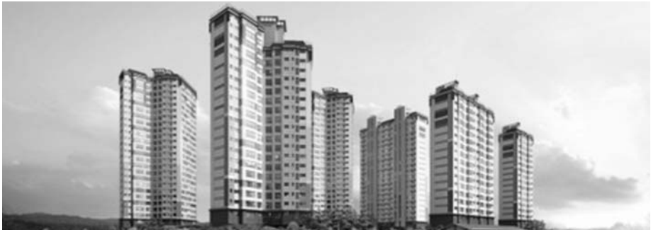
전주시 완산구 평화동 일대에 들어서는 '평화동 광신프로그램'은 올전세 또는 적절한 임대료만 부담하면, 8년까지 안심하고 거주할 수 있어 주거의 안정성이 보장된다. 또한 다양한 임대조건을 입주자가 선택할 수 있고 집을 구매하지 않기 때문에 취득세, 등록세, 재산세 등 주택보유에 대한 세금 부담이 없다.
