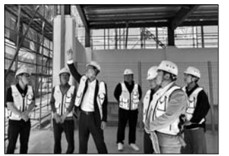
전북개발공사는 전주 상림동에 위치한 수소충전소 구축현장 안전점검을 실시했다고 밝혔다.
