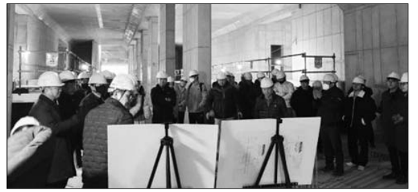
도·시군 건설관련 공무원·토목학회 회원 80여명은 광주도시철도 건설현장을 찾아 지하공사 현장 문제해결 능력 배양을 위해 견학을 실시했다.
