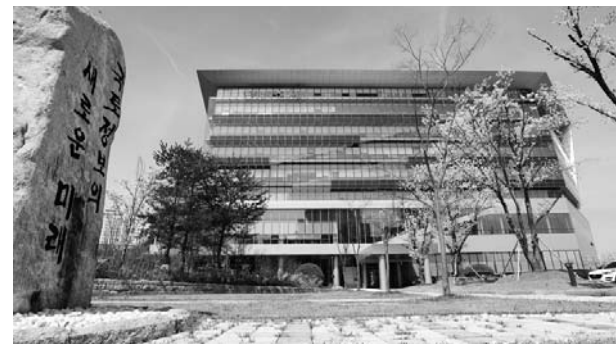
LX는 중소벤처기업부가 주관하는 2020도 공공기관 동반성장 평가에서 준정부형 내 최고등급인 '최우수'를 달성했다고 26일 밝혔다. 사진은 LX 본사 전경.
