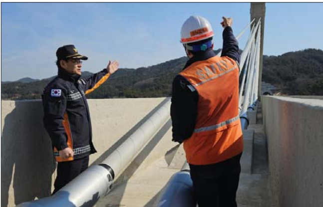
박덕규 전주완산소방서장은 27일 관내 고속도로 공사현장인 새만금-포항 간 고속도로 공사현장을 직접 방문하여 긴급안전점검을 실시했다.
