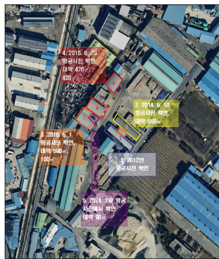
천일제지 건축법 및 건축물 관리법 위반 항공사진
