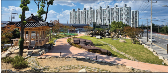
전주시가 유휴 공간으로 방치될 수 있었던 팔복동 일대 우수저류시설의 상부를 시민들이 휴식을 취할 수 있는 공원으로 탈바꿈시켰다.
