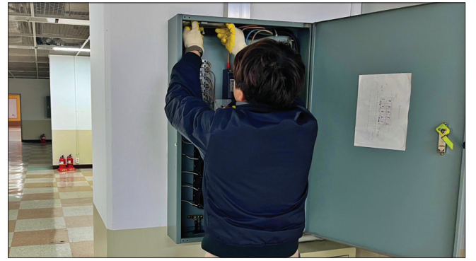
초기 전기화재 대응을 위한 '자동소화용구'를 설치하는 모습. (사진=전주시설공단 제공)
