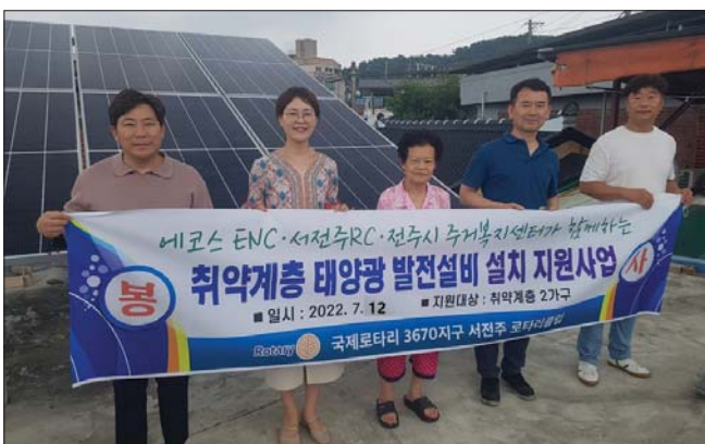
전주시 주거복지센터(센터장 오은주)와 서전주로타리클럽(회장 문우진), ㈜에코스ENC(대표 이병섭)는 최근 열악한 주거환경에서 거주해온 완산구 소재 주거취약계층을 찾아가 가정용 태양광 발전 설비를 무료로 설치했다.
