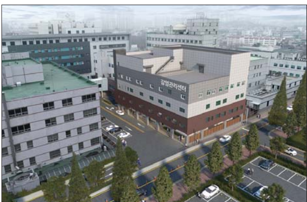
전북대학교병원이 코로나19를 비롯한 국가적 감염병 재난에 안전하게 대비하기 위해 국립대병원 최초로 전국 최고 수준의 감염관리센터를 준공했다.
