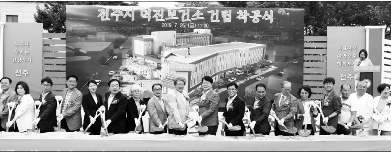
전주시는 26일 덕진보건소 신축부지인 우이동 3가 747-80번지 일원에서 김양원 전주부시장과 박병술 전주시의회 의장, 도·시의원, 유관기관, 지역주민 등 200여명이 참석한 가운데 덕진보건소 건립의 성공적인 완공을 기원하기 위한 착공식을 가졌다.
