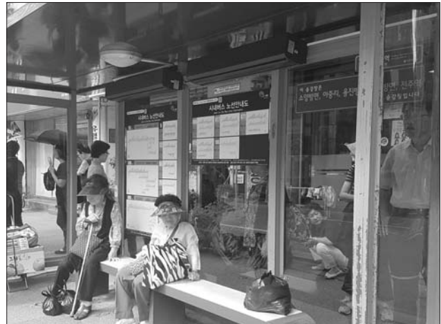
전주시가 한여름 무더위 속에서 버스탑승을 대기하는 시민들을 위해 더운 바람을 차단해 시원하게 만들어주는 에어커튼을 설치하기로 했다.
