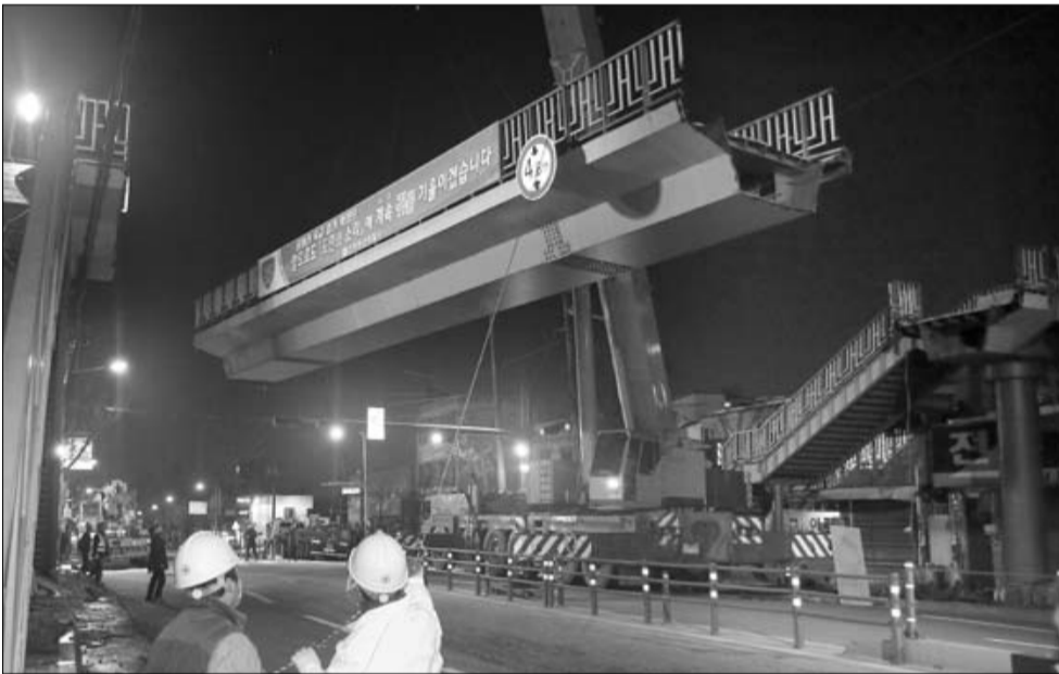
전주 용머리고개 육교 '역사속으로' 24일 오전 전주시 완산동 용머리고개 육교 철거현장에서 관계자들이 절린 육교 상판을 대형 크레인으로 옮기고 있다.
