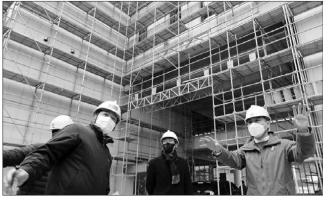
김승수 전주시장은 8일 전주정보문화산업진흥원 내 전주 신산업융복합 지식산업센터 조성 현장을 방문해 추진상황을 점검했다.
