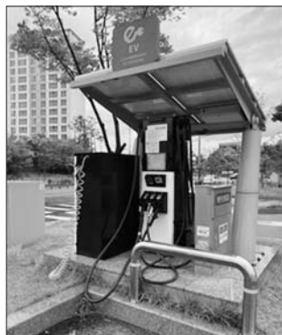
전주시는 시청 인근 외부 주차장에 급속 전기차 충전기 2개를 설치한다.
