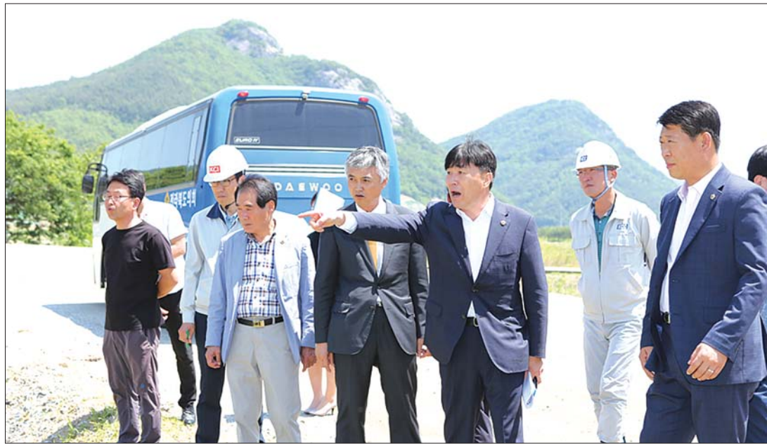
도의회 문건위 현장점검 전북도의회 문화건설안전위원회는 18일 제332회 임시회 기간 중 임실 계곡~신덕간 국지도 확포장 공사 현장 방문해 안전관리 실태를 점검했다. 이날 문건위원들은 공사 현장에서 책임감리원으로부터 계곡~신덕간 국지도 확포장 공사 사업개요 및 추진상황, 공사 현장에 반영된 교량, 터널, 사면공법 등에 대한 설명을 듣고, 중요·대형공사의 시공 과정에서 안전·품질 확보 중요성을 강조했다.
