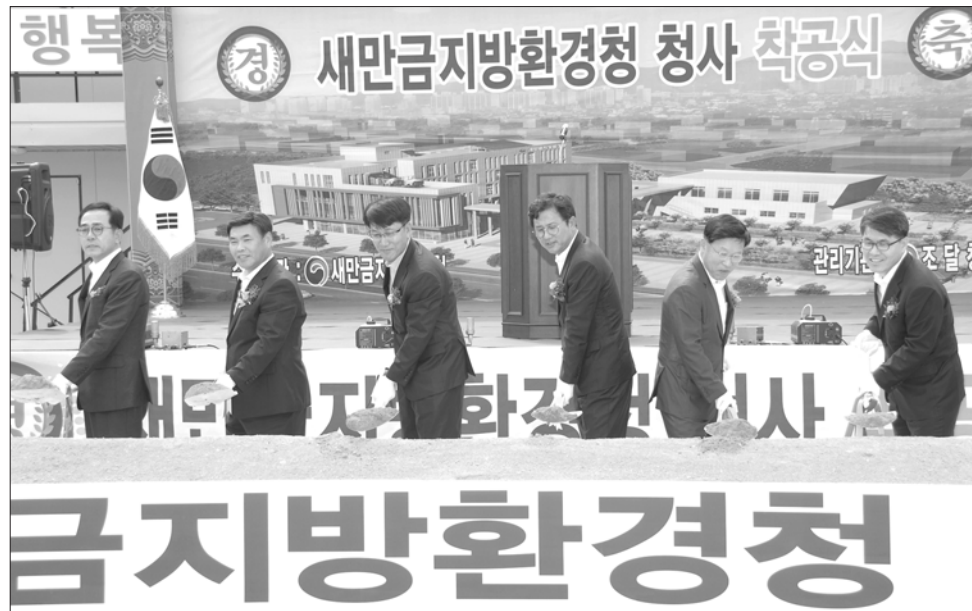
새만금지방환경청 신청사 착공식 이정섭 환경부 차관이 8일 전주·완주혁신도시 부지 내 새만금지방환경청 신청사 착공의 첫 삽을 뜨고 있다.
