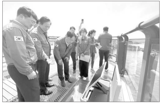
최병관 전북특별자치도 행정부지사가 고군산군도의 장자교 스카이워크 현장을 찾아 안전 점검을 실시하고 있다.
