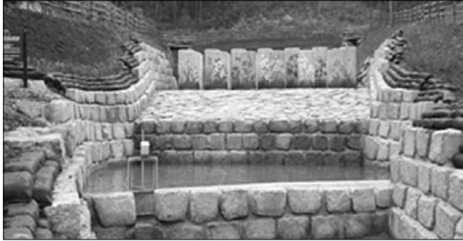
전북도 산림환경연구소는 집중호우 시 발생하는 산사태 등 산림재해를 예방하기 위한 사방사업을 추진한다. (사진은 사방댐(에코필라) 모습.)
