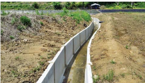
농경지 배수시설 정비
