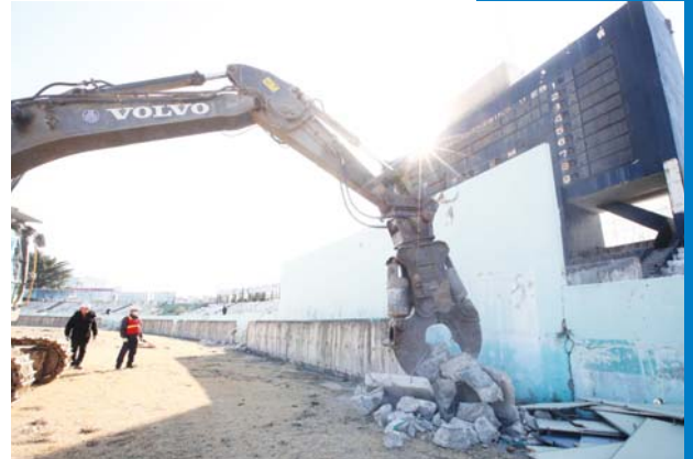
종합경기장 야구장 철거 현장.
