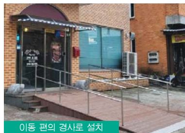
이동 편의 경사로 설치
