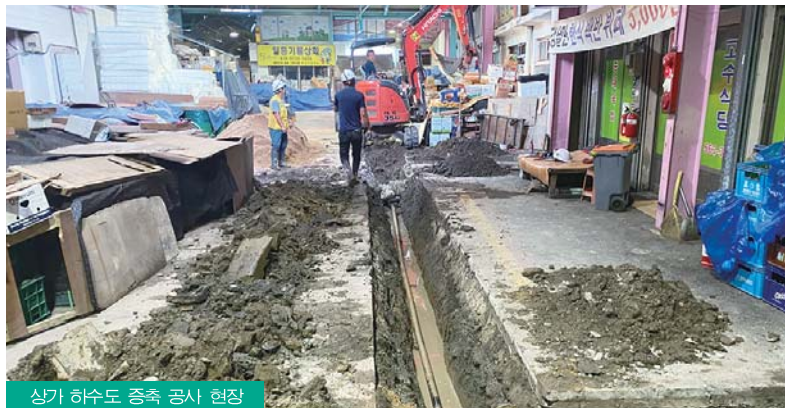
상가 하수도 증축 공사 현장
