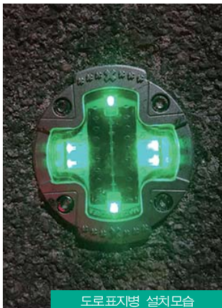
도로표지범 설치 모습
