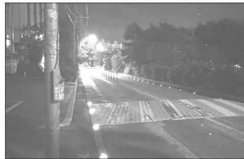
정읍시 내장상동은 야간 도로 교통사고 예방을 위해 행정복지센터 앞 도로 310m 구간에 태양광 LED 도로표지병 152개를 설치했다.
