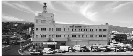
설비 설치 △건설현장 임시 소방시설 확대 △최초점검제도 도입 △화재안전관리 강화 등이 있으며, 건축물 준공 후 사용승인일 또는 소방시설 완공검사증명서를 받는 경우 60일 이내 종합점검을 받는 점검 제도 최초 도입 등이 있다.
