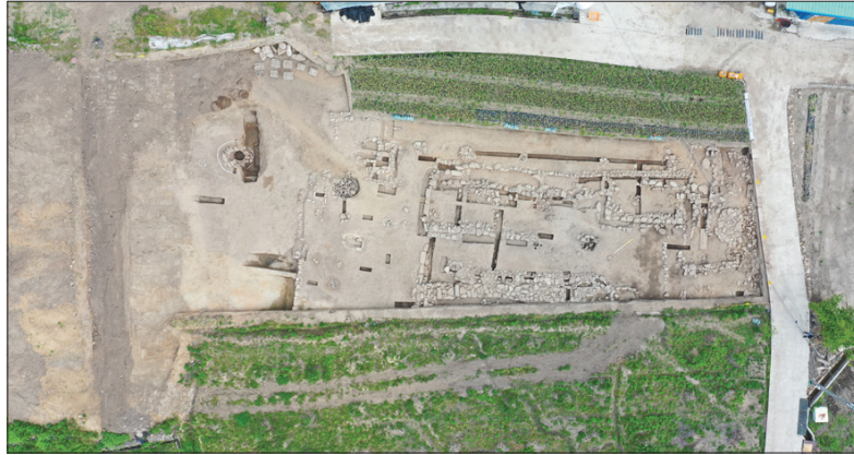
장수 개안사지 전경
