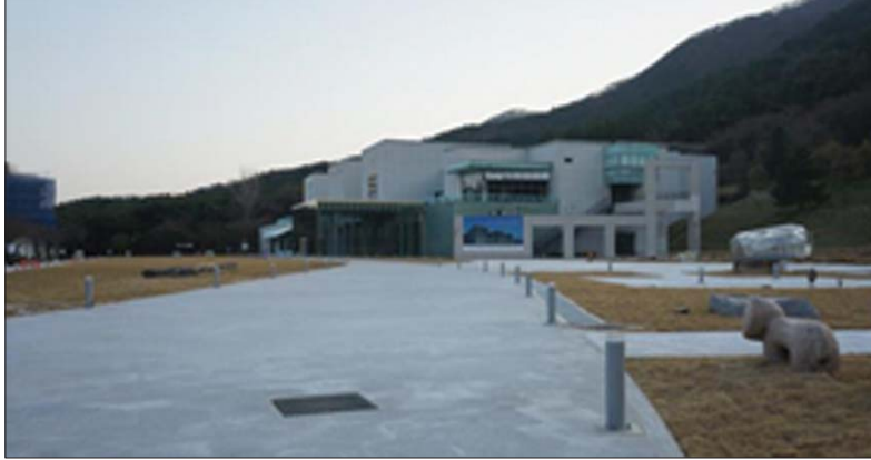
전북도립미술관 야외정원과 건물 외관 리모델링 경관.
