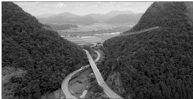
순창군의 랜드마크가 될 체계산 출렁다리 공사가 순조롭게 진행 중이다
