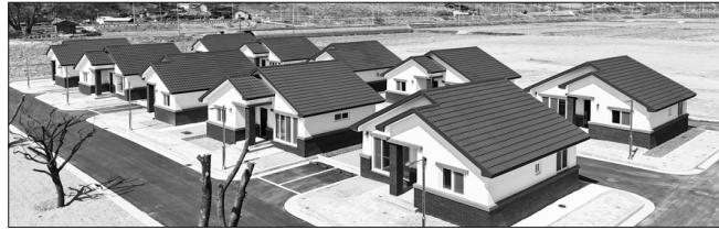
오수 귀농인 임시거주시설 전경.
