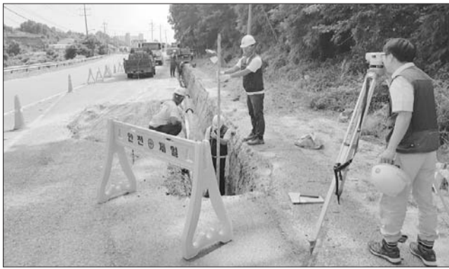
완주군은 환경부 공모 지방상수도 현대화사업 대상지로 최종 확정되면서 297억원 규모의 사업을 추진한다.
